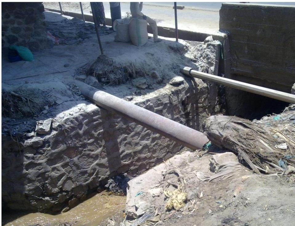
*Illustration 44. Réparation provisoire sur conduite DN 200 F (à gauche) au point de passage de la Nyabagere au pont de Kamenge*
