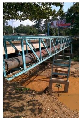
*Illustration 43. Réparations provisoires sur conduites DN 300 A (à gauche) et DN 700 F (à droite) - pont du Peuple Murundi*
