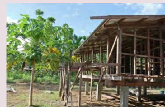
Construction de maisons dans les îles Salomon. Source : Banque mondiale
