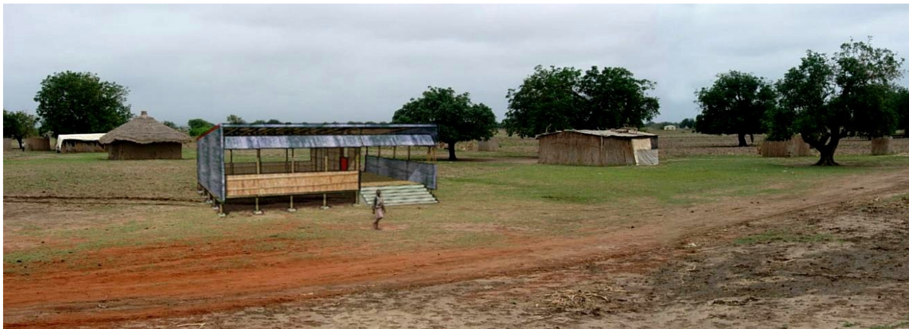
Figura 19: Exemplo de uma intervenção prioritária implementada: construção de uma sala de aulas elevada numa zona susceptível às cheias utilizando material local
