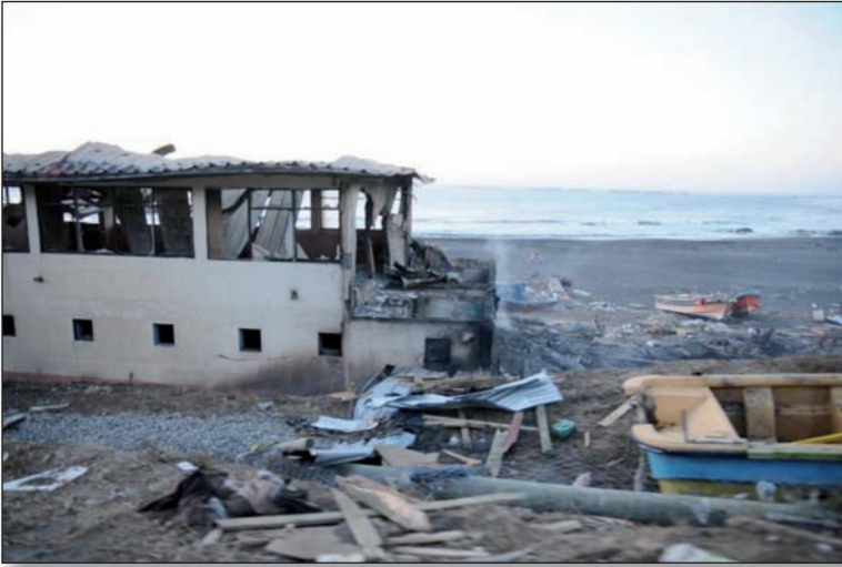
Figura 3: Daños en el borde costero de la Región del Maule.
