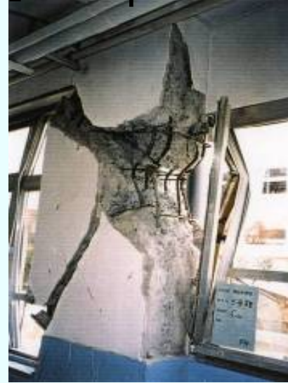
【Collapse of columns and beams】
