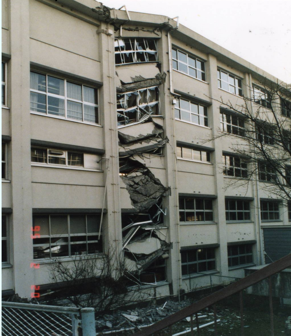
【Collapse of columns and beams】
