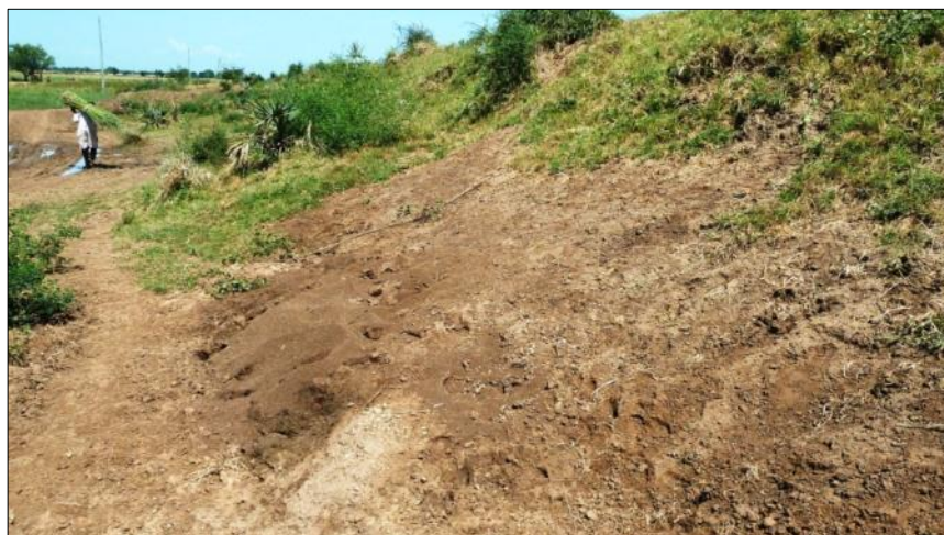
Figure 12. Invasion de colonies de fourmis dans le talus à l'aval du barrage de Maga, près de Pouss; septembre 2012
