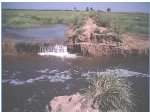
Figure 22. Dégâts et réparations de campagne dans la digue de Logone: a) Débordements ayant failli détruire la digue de Logone, près de Yagoua; b) Infiltrations dans la digue de Logone, près de Yagoua; c) Brèche ouverte sur la digue de protection à Pouss en 2011 (Source: ERE Développement, 2012)
