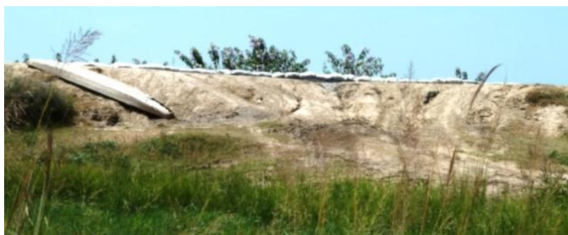
Figure 13. Érosion, causée par des débordements, ayant failli détruire le barrage de Maga
