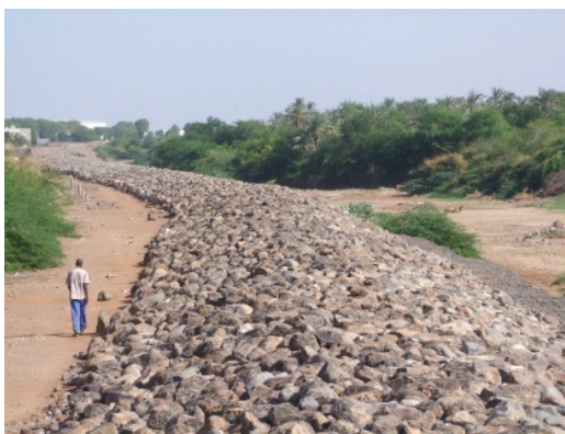
Digue d'Ambouli-Djibouti Ville
