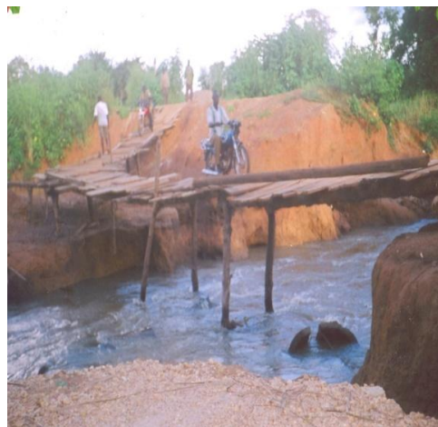
Ouvrage de fortune pour le franchissement du cours d'eau/après destruction du ponceau
