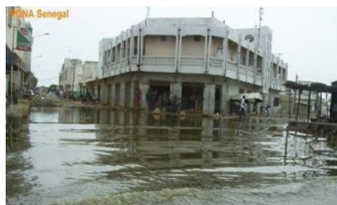
Photos 11 et 12 : logements et ruelles envahis suite aux inondations de 2009
