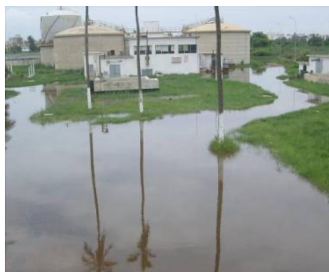
Photo 7 : la station d'épuration de Cambérène envahie par les eaux
