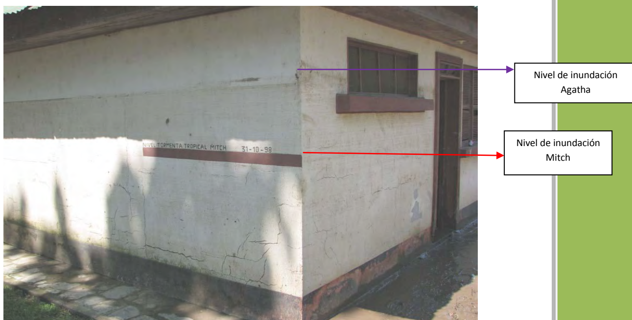
Foto 6: Comparación entre el nivel del agua alcanzado por la Tormenta Mitch y la Tormenta Agatha
