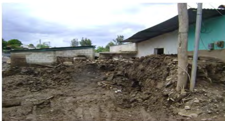
Foto 5: Vivienda, viviendas destruidas y en riesgo
