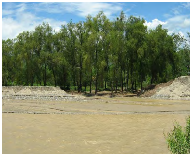
Foto 12: Destrucción de borda longitudinal en el río Motagua en Gualán.
