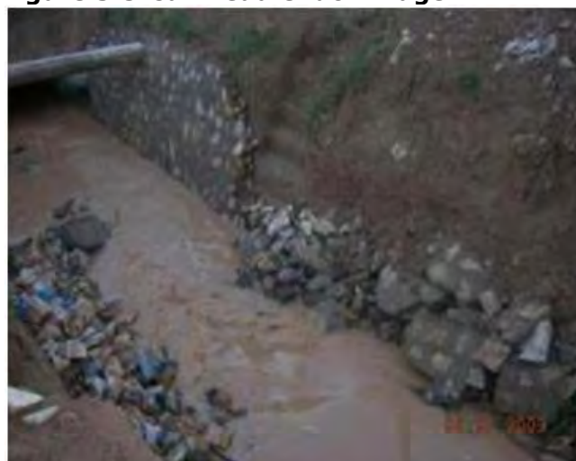
Figure 3-9 Caniveau endommagé
