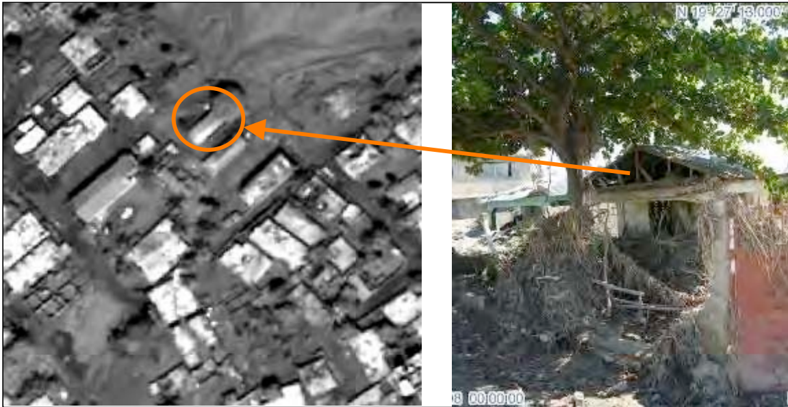
Figure (b) – La maison mise en évidence sur l'image satellitale (gauche) a une largeur de 5m.
