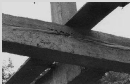
Рис. 3.4. Мусор в опорных бетонных балках
