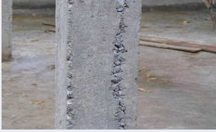
الشكل ٣-٥ تصميم بشكل «قرص العسل» يبين عملية تشييد رديئة
