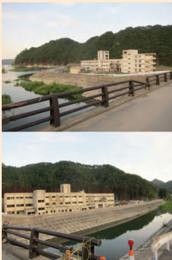
図2：釜石東中学校（上）と鶴住居小学校（下）の両校とも海に近い。
