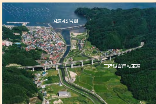
図2：三陸縦貫自動車道。津波を念頭に置いて建設された道路
