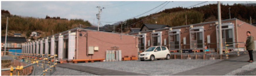
元の自宅周辺に建設された小規模な仮設住宅グループ
