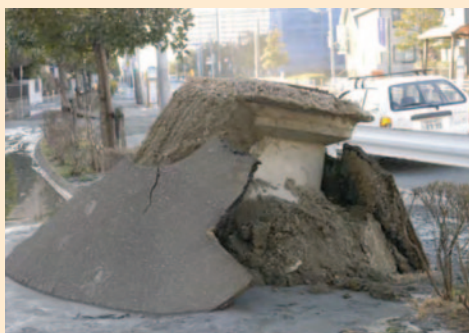
図4（右）：浦安市の液状化によるマンホール浮き上がり
