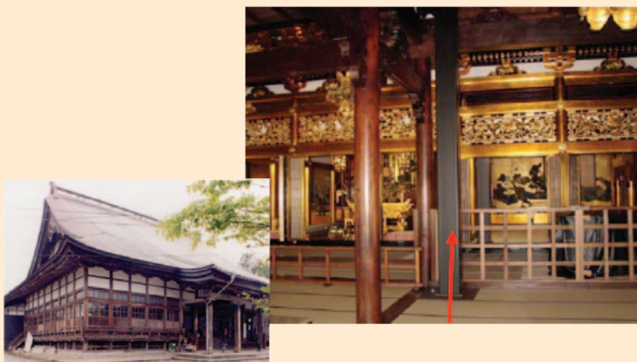
図7：常光寺改良工事
