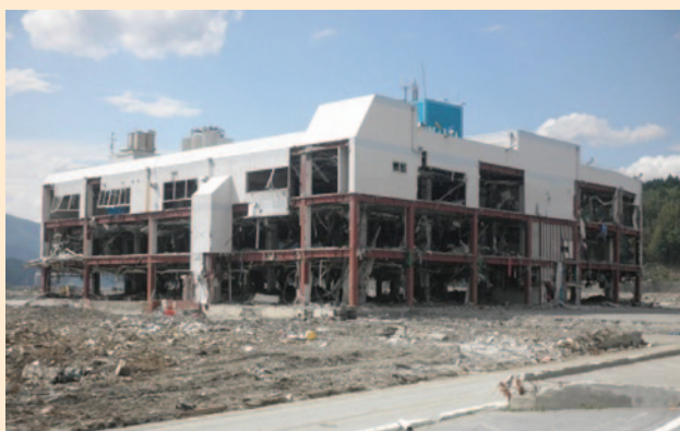
図4 (下) : 浸水を受けても津波に持ちこたえた鉄筋コンクリートの建築物。 車両が屋根の上にあるのに注意
