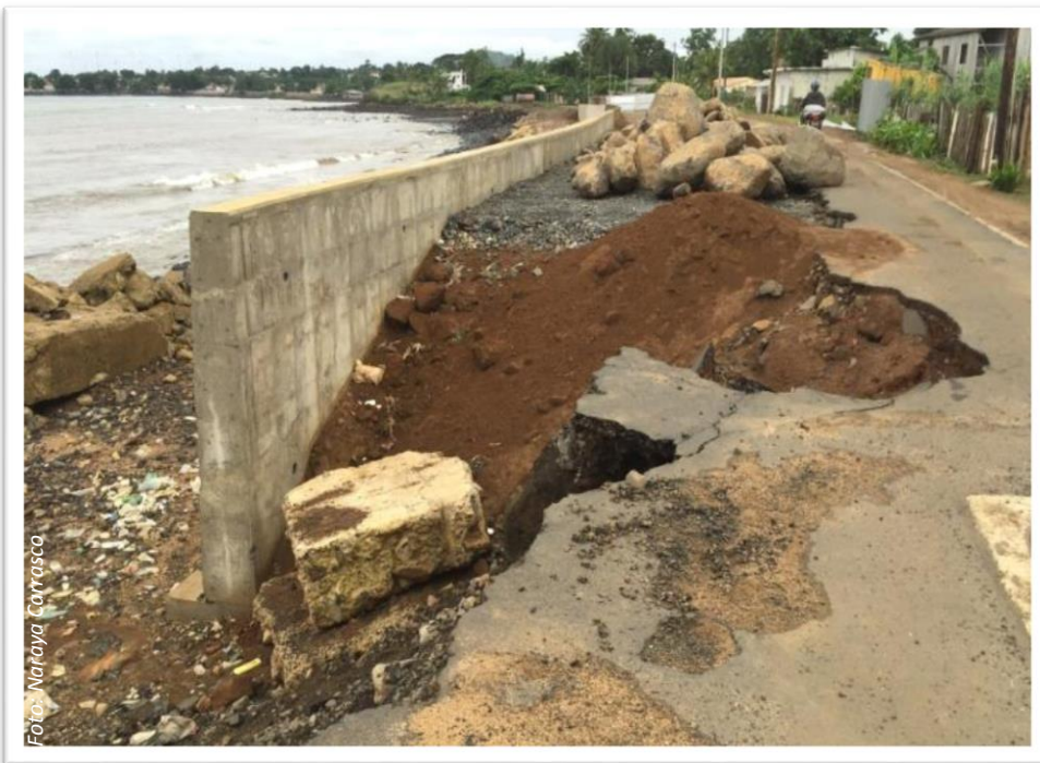
Figura 16: Estrada destruída por erosão pelo mar na zona costeira. Um muro de contenção está em construção para substituir o troço anterior (vestígios ainda visíveis) e proteger a estrada.
