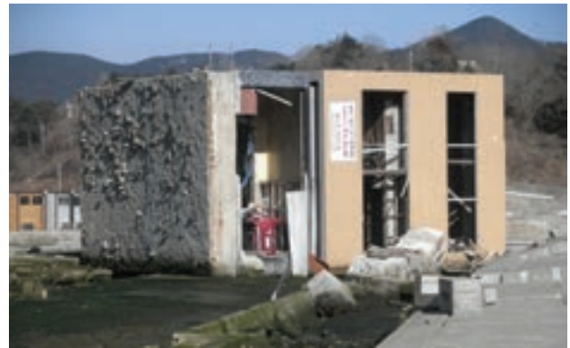
図2.5 浮力により横転した鉄筋コンクリートの建築物
