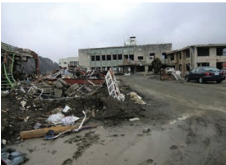
図17.1 津波で損壊した大槌町役場 出所：石渡幹夫
