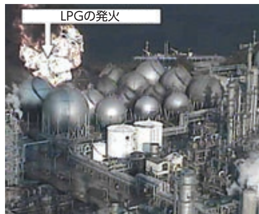
図5.5 精油所で漏出したLPGの発火
