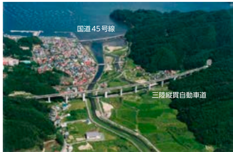
図4.2 三陸縦貫自動車道は津波を念頭に置いて建設された 出所：国交省
