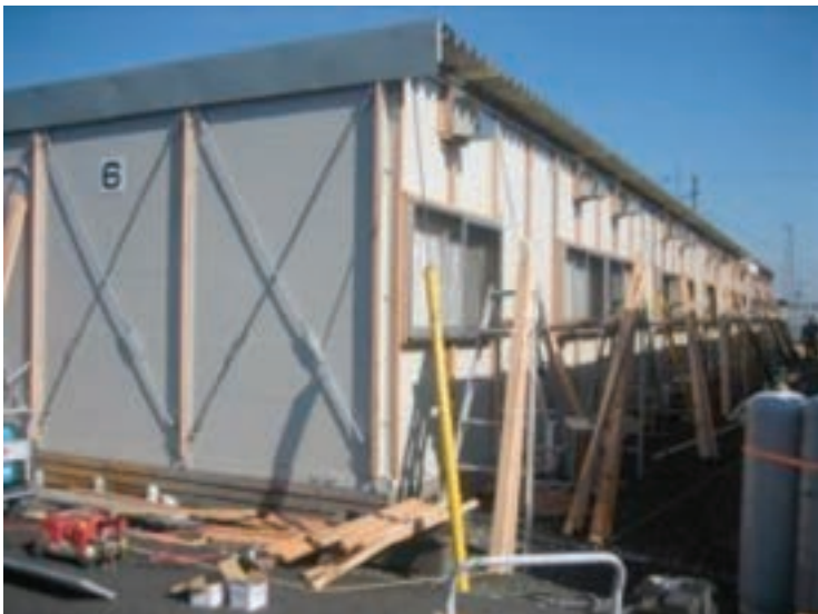
図 22.5 仮設住宅の改善～断熱材と二重窓ガラスを追加
