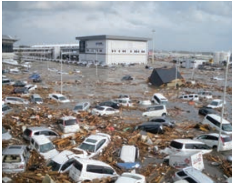
図20.2 津波直後の仙台空港
