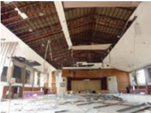
図2.8 落下した学校の体育館の天井板
