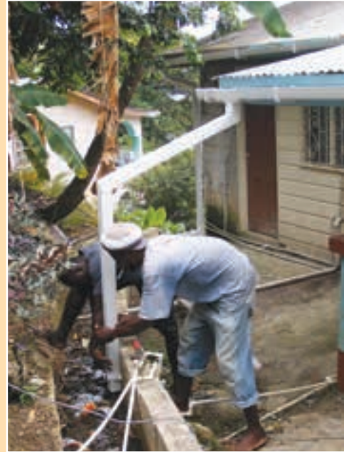
FIGURA 7.24 Conexiones del agua del tejado de las viviendas a los drenajes principales
