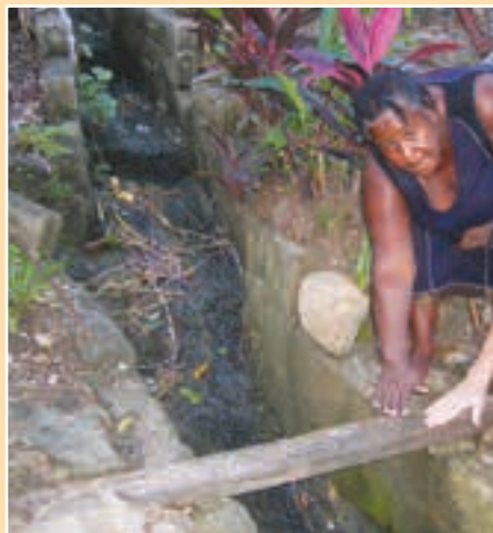
FIGURA 9.3 Máximo nivel del caudal observado en un drenaje MoSSaiC durante el huracán Tomás
