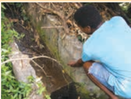
b. Un residente indica la profundidad máxima del caudal observada en un drenaje construido recientemente durante una tormenta.
