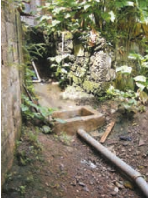
FIGURA 7.25 Arquetas de conexión en hormigón
