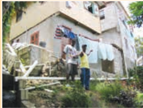
a. Conexión de agua del tejado de una vivienda a un drenaje principal cercano.
