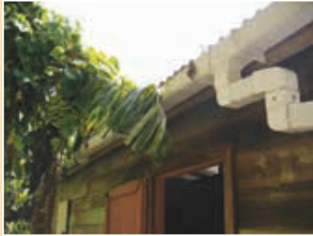
FIGURA 7.4 Detalles de instalación de las bajantes
