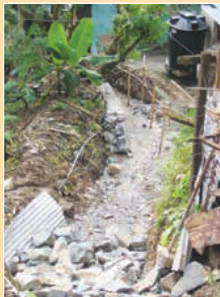
FIGURA 6.26 Muro de derrubios como parte de la construcción del drenaje
