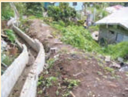
FIGURA 6.21 Construcción de drenaje encima de una pendiente que ha fallado
