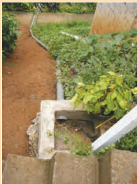
FIGURA 6.41 Arquetas de hormigón que conectan el agua de varias casas a un solo punto de recolección con una tubería de salida al drenaje principal
