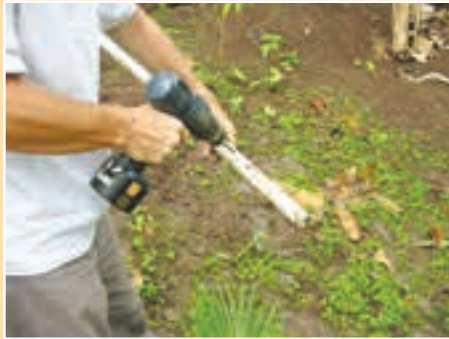
b. Perforar orificios en el tubo del piezómetro.
