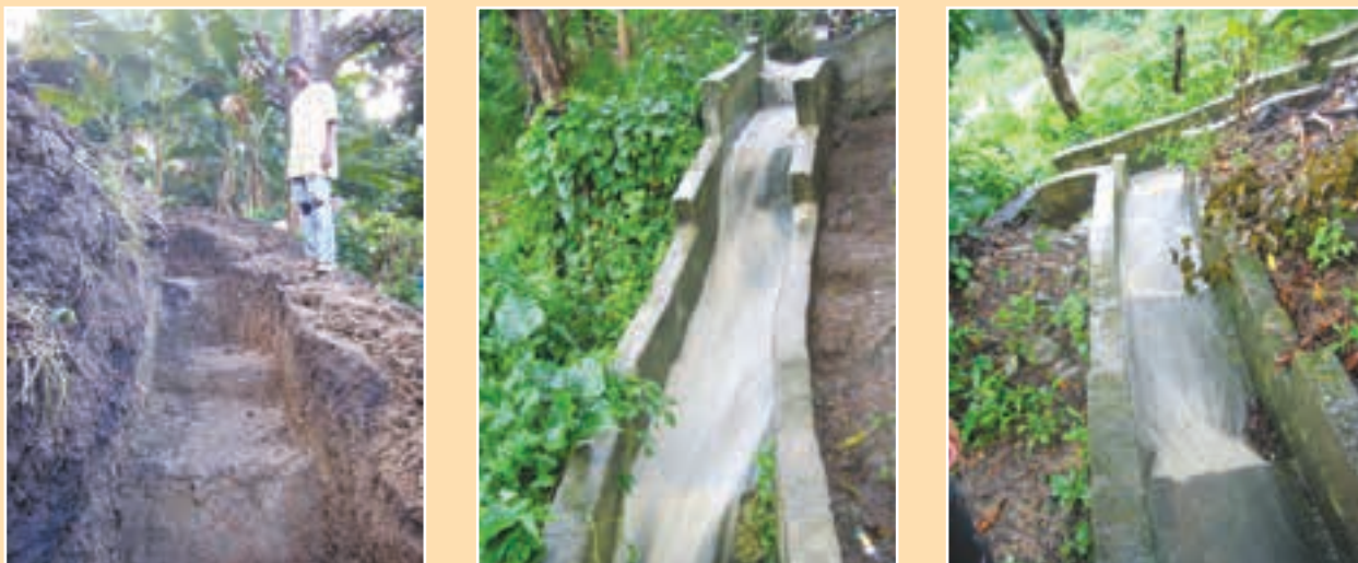
FIGURA 7.18 Drenajes escalonados de auto limpieza
