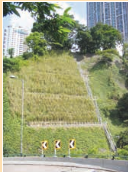
FIGURA 7.37 Bioingeniería aplicada a pendiente en Hong Kong SAR, China
