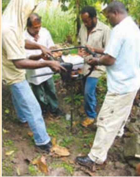
a. Perforar para instalar un piezómetro.
