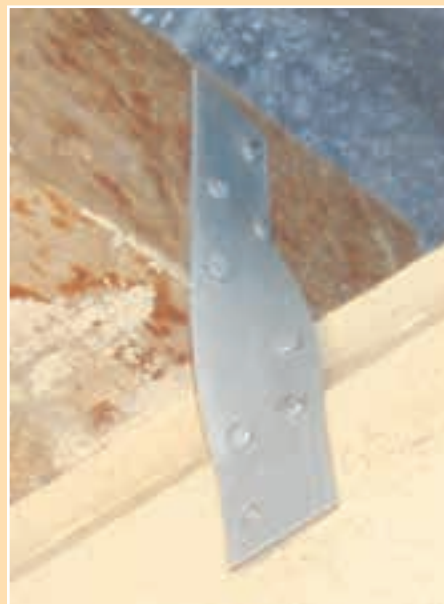
FIGURA 6.44 Zuncho para huracanes en el tejado
