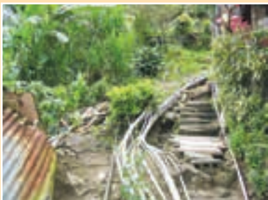
a. La vivienda no autorizada a menudo recibe el suministro de agua por medio de tuberías plásticas.
