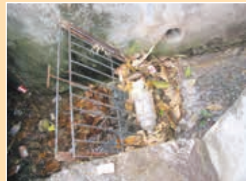
FIGURA 8.18 Las rejas de derrubios se deben instalar y limpiar habitualmente
