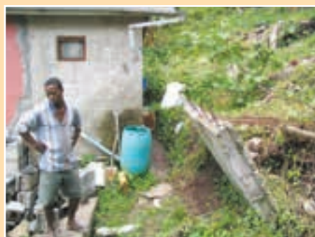
b. Un residente en el área de inestabilidad de la pendiente adyacente a su casa antes de la intervención MoSSaiC.
