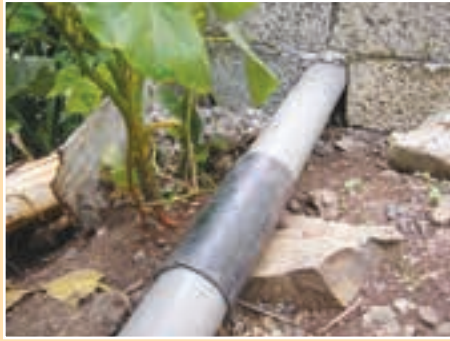
FIGURA 7.29 Utilizar manguitos para unir las secciones de tuberías de drenaje
