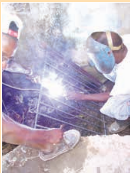
FIGURA 7.39 Soldadura en el sitio y terminación de la reja de derrubios
