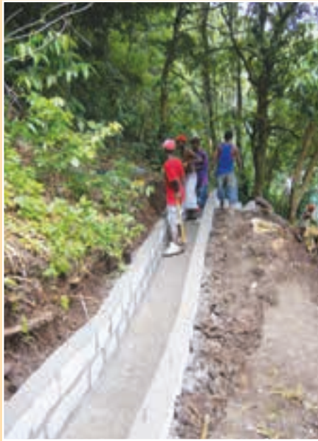
FIGURA 6.17 Drenaje de interceptación principal transversal a la pendiente construido con un ángulo de inclinación de 35 grados
