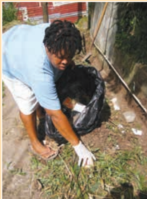
b. Eliminar la vegetación que puede bloquear el drenaje.
