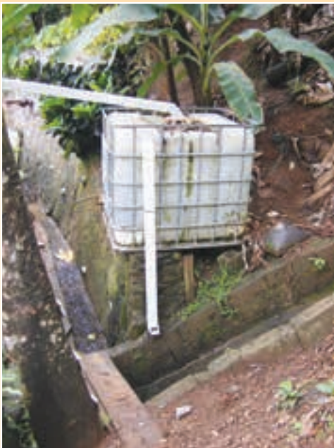
FIGURA 7.26 Conexión de las tuberías de desbordamiento del tanque de agua a los drenajes cercanos
