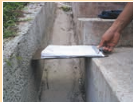
FIGURA 7.32 Identificar la capacidad máxima del drenaje adyacente a los escalones del sendero
