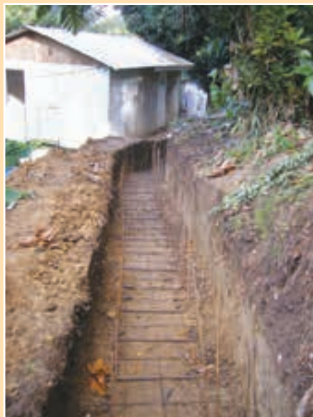
FIGURA 7.17 Ejemplo de problemas de alineación detallada encontrados al inicio de la construcción
