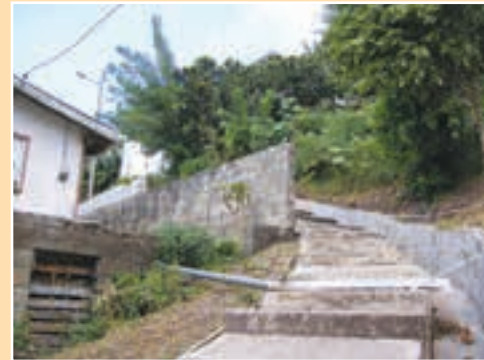
b. Se deben proveer conexiones de agua a las viviendas antes de construir un sendero.
