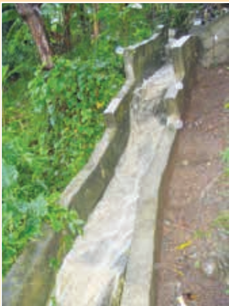
a. Descarga en un drenaje escalonado durante una tormenta fuerte que indica una capacidad adecuada.
