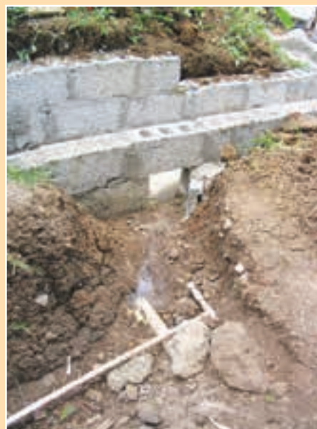
FIGURA 7.21 Construcción del drenaje previendo una posible conexión con tuberías de aguas grises
