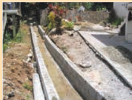
FIGURA 7.19 Altura del muro del drenaje terminado a nivel de la superficie del terreno adyacente
