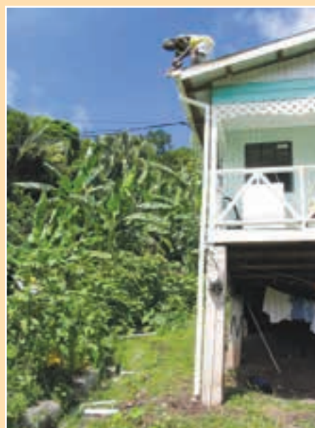
FIGURA 6.34 Retroadaptación de canalones de tejados
