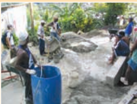
b. Planificar dónde se puede mezclar el cemento.
