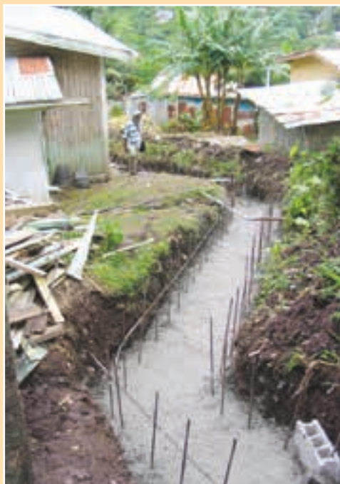
a. Un vertido de la base del drenaje bien construido en buenas condiciones climáticas.
