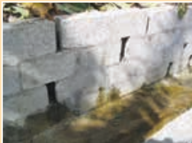
FIGURA 7.20 Formación de los orificios de drenaje
