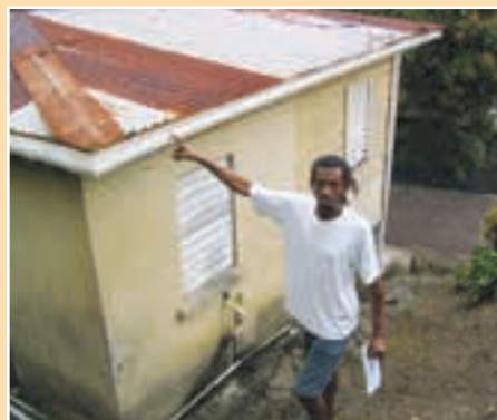
FIGURA 7.23 Canalones de tejado recientemente instalados
