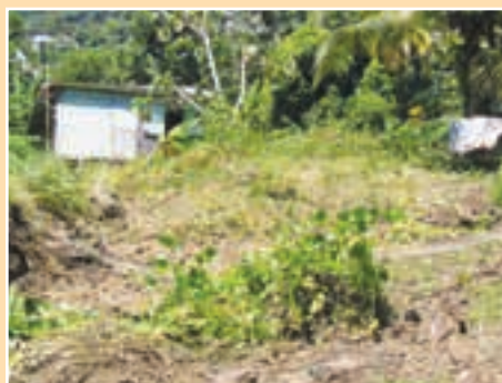
FIGURA 5.16 Evidencia de movimiento menor de la pendiente
