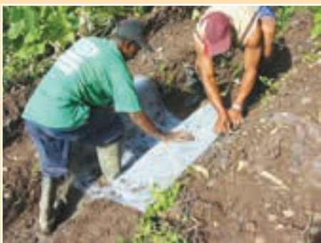
a. Los residentes instalan un drenaje de bajo costo.
