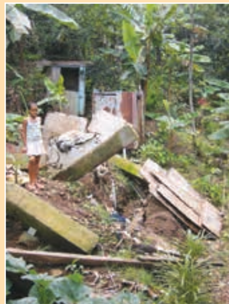
b. Deslizamiento menor donde el impacto de los derrubios ha destruido una casa de madera.
