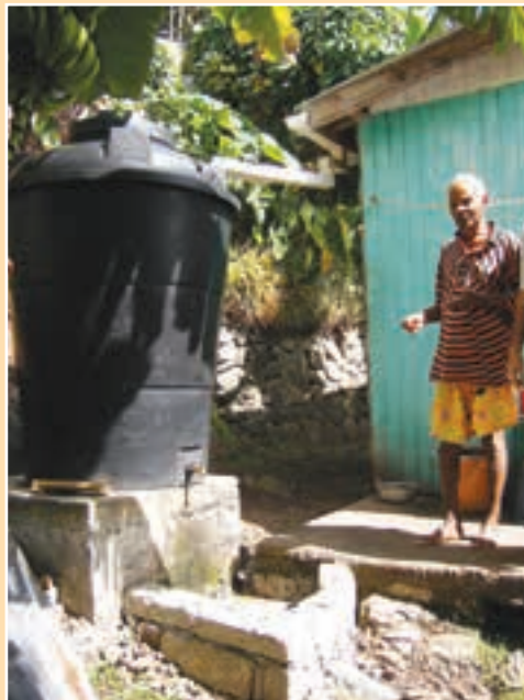
FIGURA 7.26 Conexión de las tuberías de desbordamiento del tanque de agua a los drenajes cercanos
