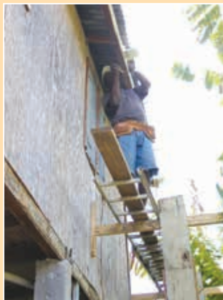
FIGURA 7.3 Modificaciones a la estructura del tejado para la instalación de canalones
