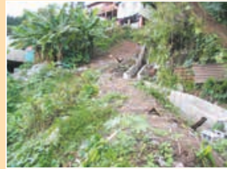
FIGURA 6.9 Drenaje alineado para interceptar el agua superficial y dirigirla alrededor de un deslizamiento mayor preexistente
