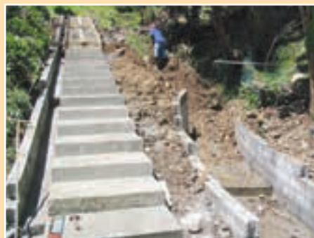
FIGURA 6.19 Ejemplos de senderos y drenajes de senderos construidos simultáneamente
