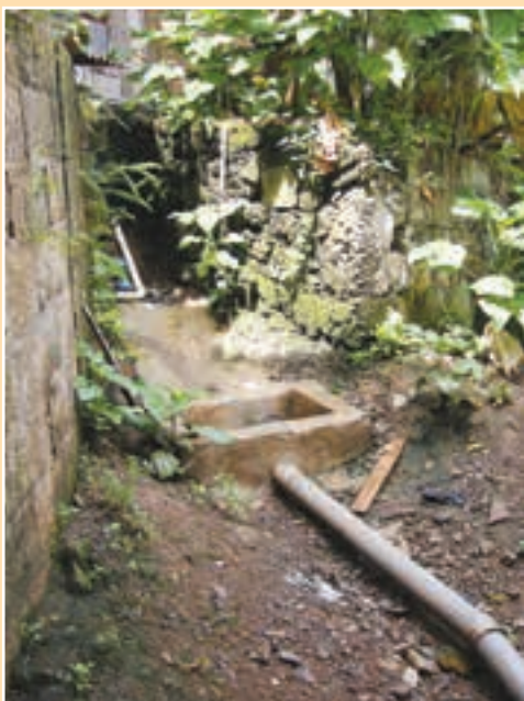
FIGURA 6.41 Arquetas de hormigón que conectan el agua de varias casas a un solo punto de recolección con una tubería de salida al drenaje principal
