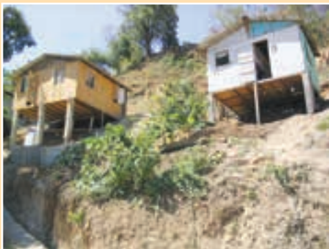
a. Viviendas no autorizadas construidas sobre un deslizamiento preexistente en el año siguiente a la producción de la falla.
