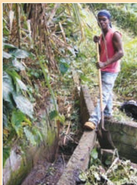
FIGURA 6.22 Mantenimiento post construcción: mantener drenajes sin derrubios
