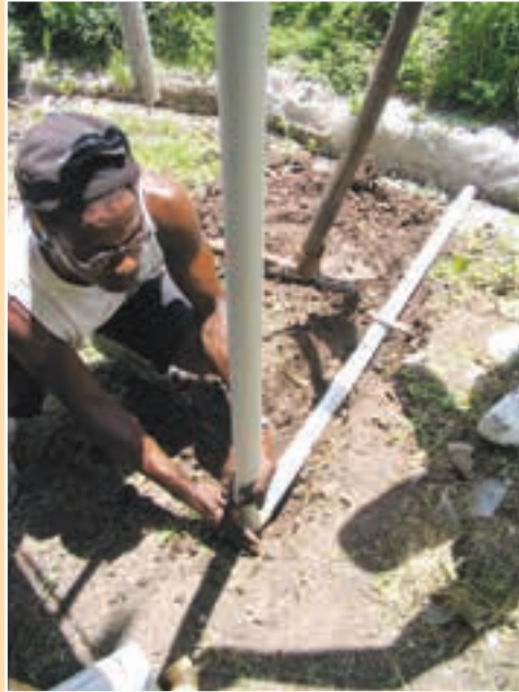
FIGURA 7.24 Conexiones del agua del tejado de las viviendas a los drenajes principales
