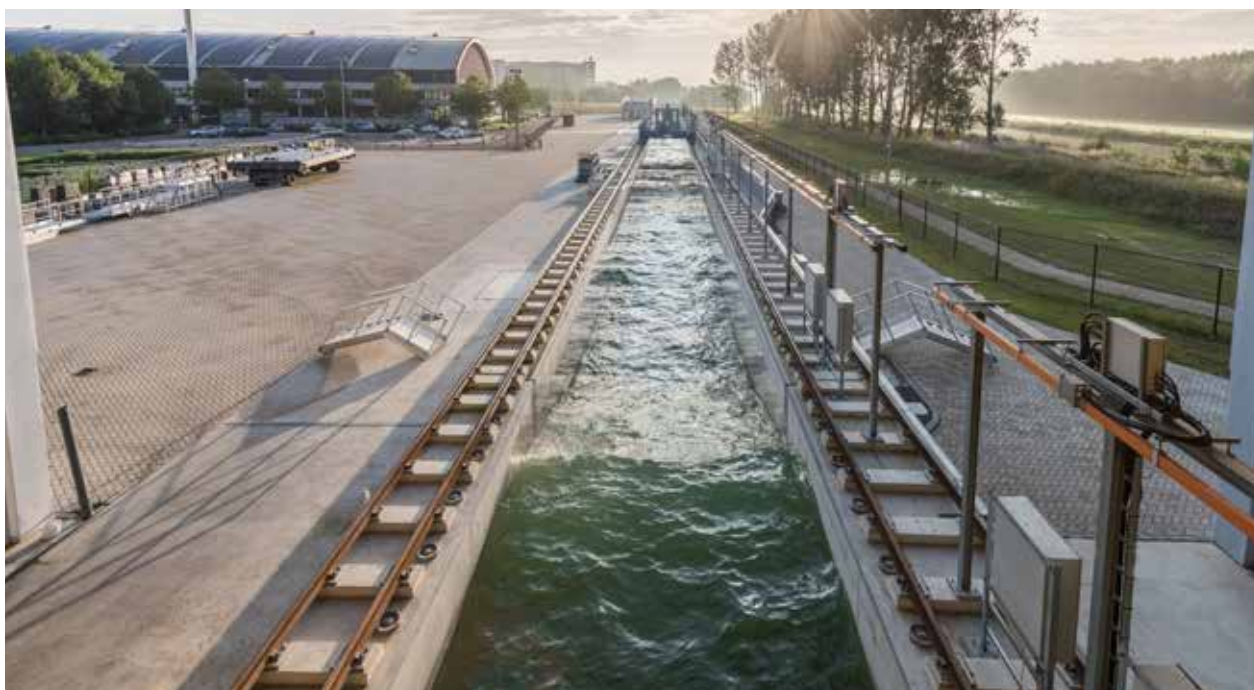
Dans les installations expérimentales comme Delta Flume, les performances de la végétation sont testées dans des conditions extrêmes
