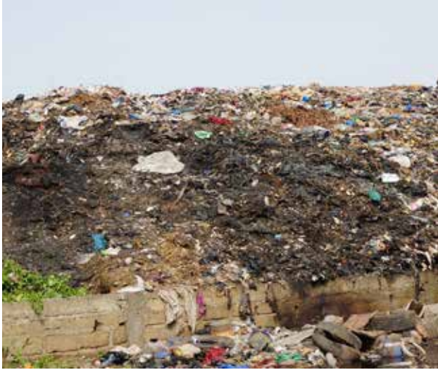
Photo 12 : Les déchets solides avaient fini d'anéantir la fonction de cette canalisation au bord de la route
