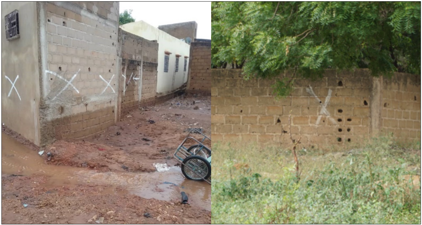
Photo 5 : Exemples de logements construits sur les servitudes d'un collecteur et marqués d'une croix blanche pour être démolis
