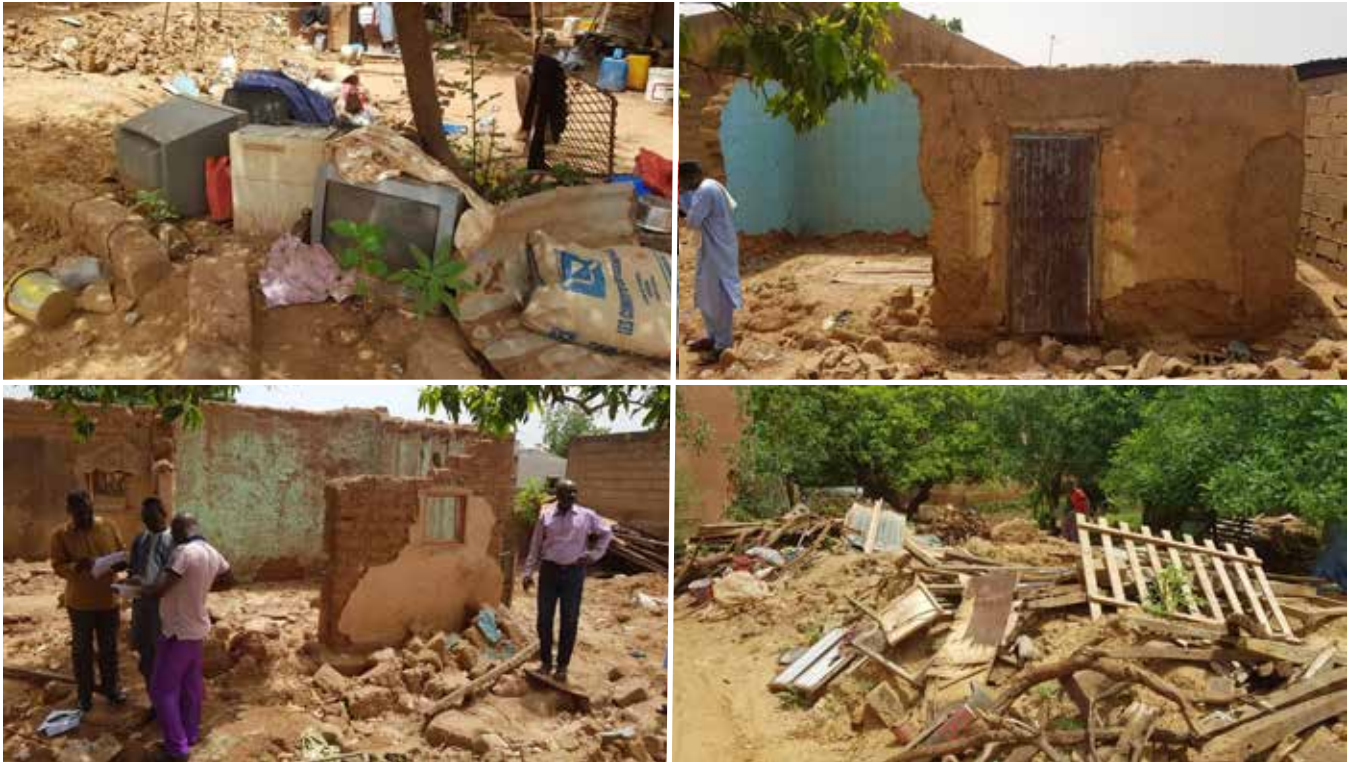
Photo 4 : Quelques illustrations des dommages subis dans le secteur Logement et Urbanisme
